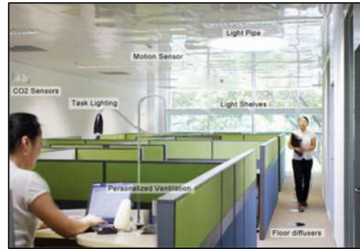
Gambar 12 Sistem HVAC Sumber : www.solaripedia.com
