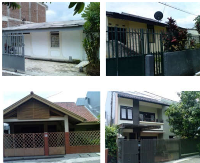
Gambar 3 Tingkat transformasi di Perumnas Sadang Serang (Original, Extended, Remodelled, dan Totally Reconstructed).
