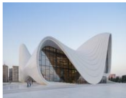
Gambar 11 Lipatan melengkung atau lipatan yang tidak memiliki batas pada permukaan)
