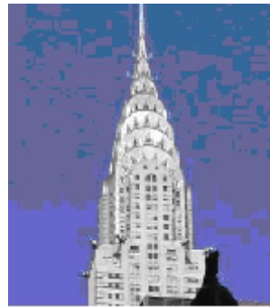
Puncak menara gaya Art Deco pada Bangunan Chrysler, dibangun 1928- 1930
