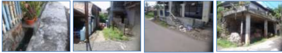
Gambar 7 : Kondisi Degradasi Daya Dukung Prasarana Lingkungan
