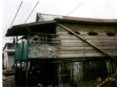
Gambar 13. Lubang Ventilasi Pada Dinding Samping
