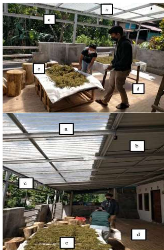
Gambar 3. Lokasi alat pengeringan bahan baku tumbuhan obat Biovina. a. Atap yang transparan (tembus sinar matahari). b. Atap tidak transparan (tidak tembus matahari). c. Rangka bangunan yang terbuat dari baja ringan. d. Lantai telah (keramik) yang
