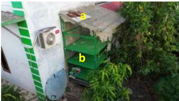
Gambar 5. Penampakan pengering CV Biovina setelah 3 tahun dibangun mengalami kerusakan(a) dan menjadi terbuka matahari(b).
