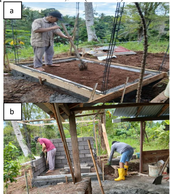
Gambar 9. Kamar mandi dan toilet dibangun yang permanen dengan sepsitank ukuran 2x1,5 m 2 (a) dan kamar mandi ukuran 2x1,5 m 2+ (b).
