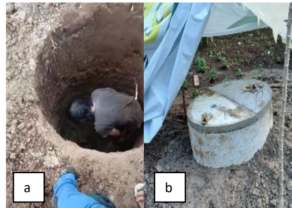
Gambar 8. Pembuatan sumur: sedang menggali lobang (a) dan sumur sudah selesai dan dilengkapi pompa (b) untuk sebagai sumber air untuk pertanian dan kebutuhan kelompok petani ibu ibu Desa Tambala setiap kerja.
