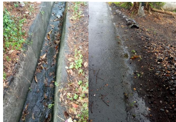
Gambar 1. Kondisi eksisting drainase
