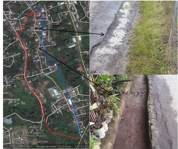
Gambar 1. Kondisi eksisting drainase
