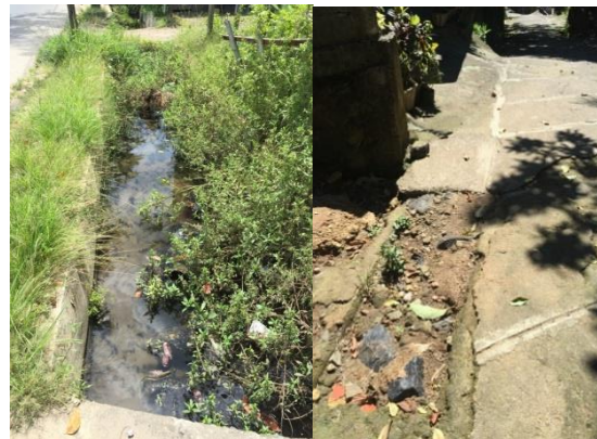
Gambar 2. Kondisi Eksisting Drainase
