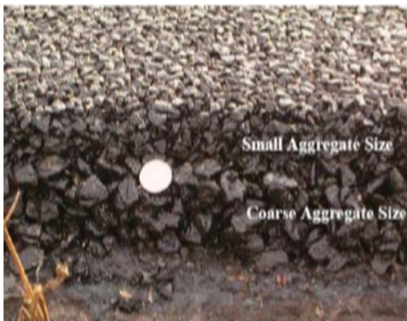
Gambar 2. Susunan lapis atas dan bawah pada perkerasan aspal porus
