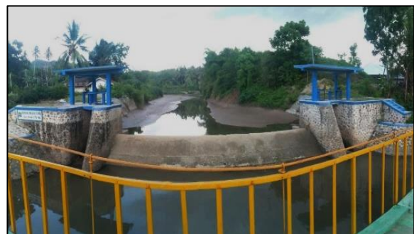
Gambar 1. Tampak Bendung Huludupitango
