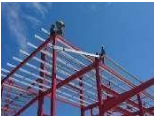
Gambar 8 Proses pekerjaan purlin
