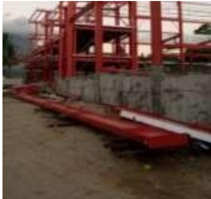
Gambar 6. Proses pembersihan rafter
