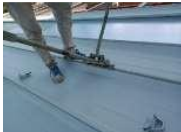
Gambar 12 Proses penyambungan atap menggunakan alat handtool
