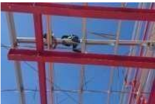
Gambar 9 Proses pemasangan sag arrestor
