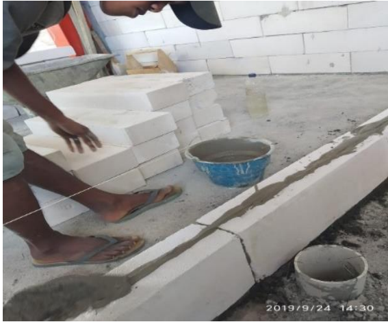
Gambar 18. Pemberian mortar MU pada pemasangan hebel lapisan berikutnya
