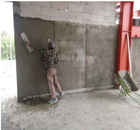
Gambar 23. Pekerjaan plesteran dinding
