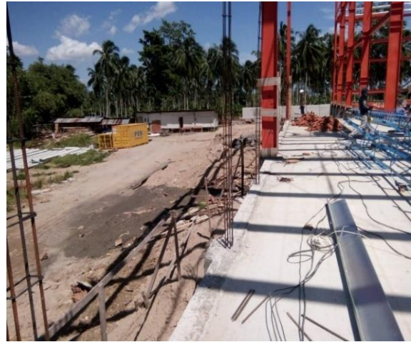
Gambar 12. Hasil pemasangan tulangan kolom praktis pada lantai
