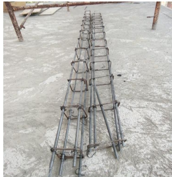
Gambar 8. Tulangan kolom dan balok praktis
