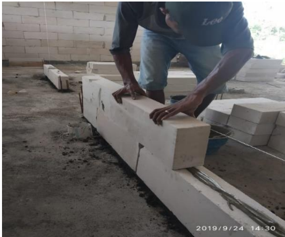
Gambar 19. Pemasangan hebel
