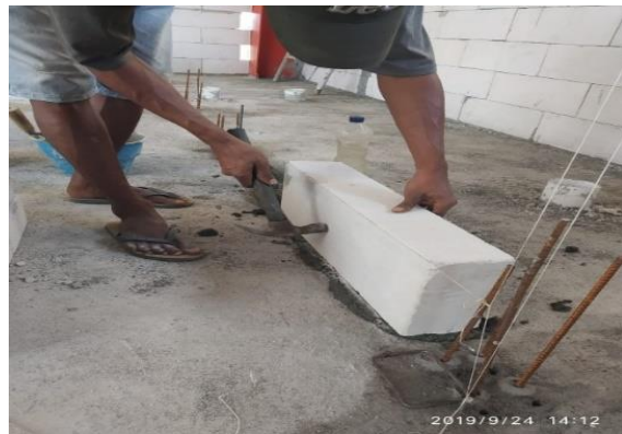
Gambar 17. Pemasangan hebel (diketok dengan palu)
