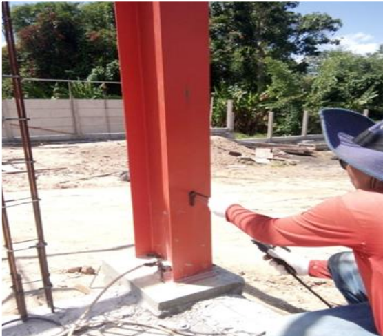
Gambar 9. Pengelasan tulangan shear connector pada kolom baja
