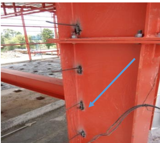
Gambar 11. Hasil pengelasan tulangan shear konektor pada kolom baja
