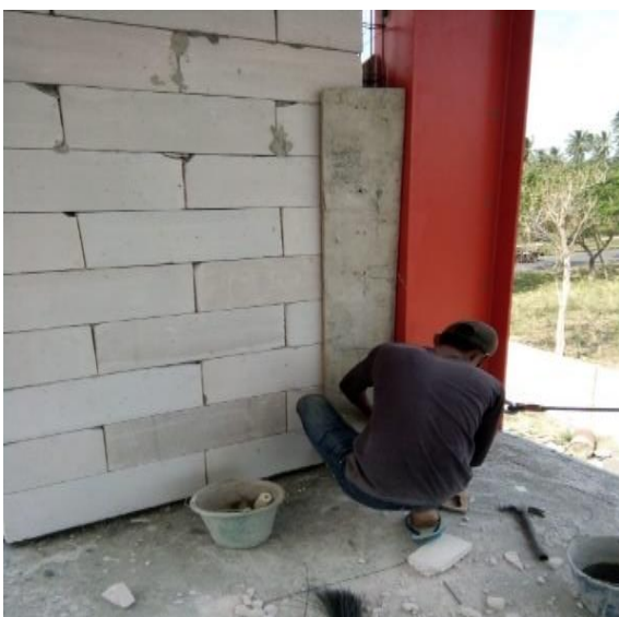
Gambar 20. Pemasangan bekisting kolom praktis
