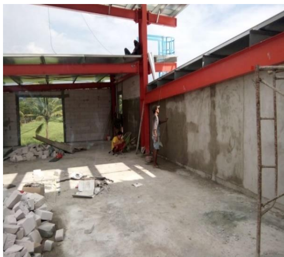
Gambar 24. Pekerjaan plesteran dinding
