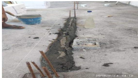
Gambar 16. Pemberian spesi pada jalur pemasangan dinding
