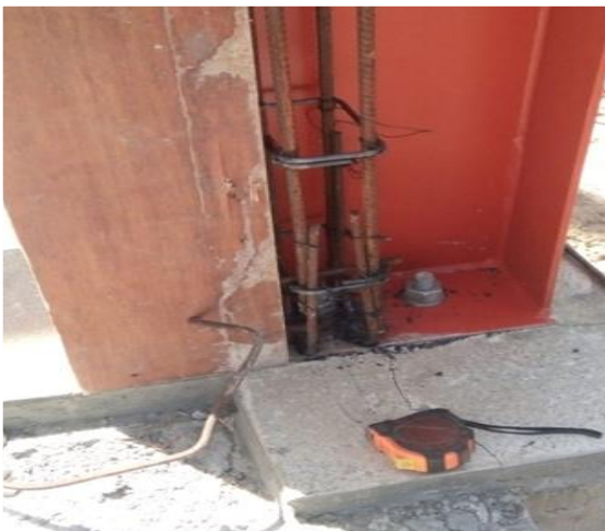
Gambar 10. Hasil pengelasan tulangan kolom praktis pada kolom baja
