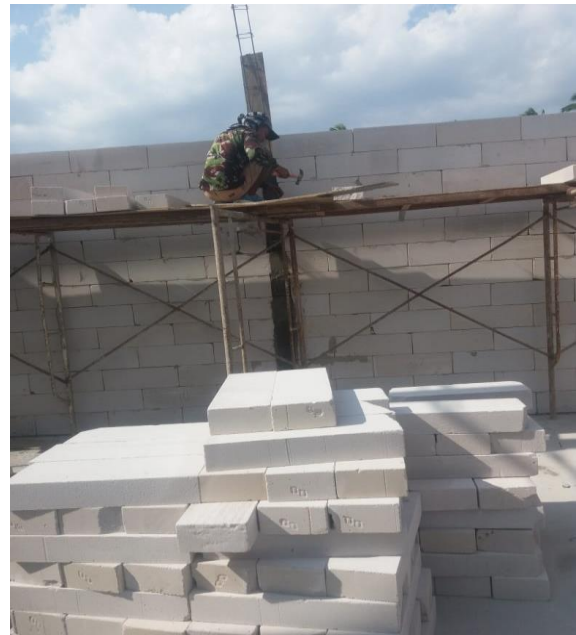
Gambar 21. Pengeoran kolom praktis bagian atas menggunakan Scaffolding
