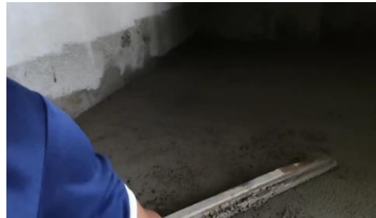
Gambar 21 Perataan menggunakan roskan
