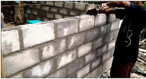
Gambar 19 Proses Pemasangan Bata
