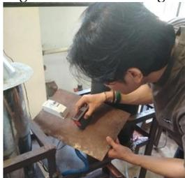
Gambar 15. Pemasangan thermostat digital kontrol
