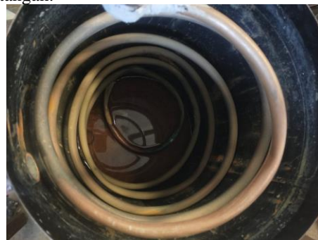
Gambar 3.13 Pembuatan Pipa Kondensator
