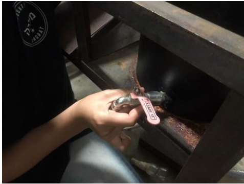
Gambar 3.20 Pemasangan keran air output produk
