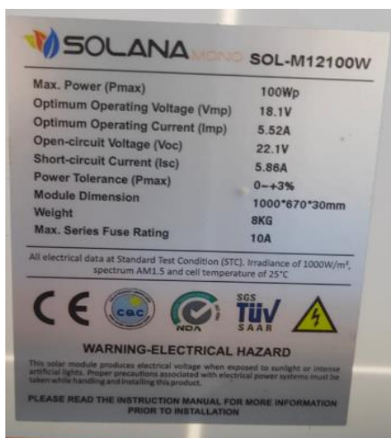
Gambar 2.3 : Parameter Solar Panel 100 PV
