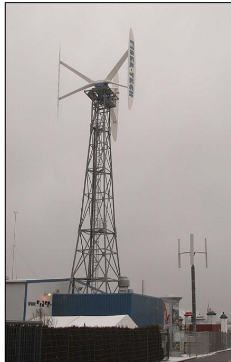
Gambar 2.1 Menara Lattice Dengan Turbin Angin Darrieus Tipe-H
