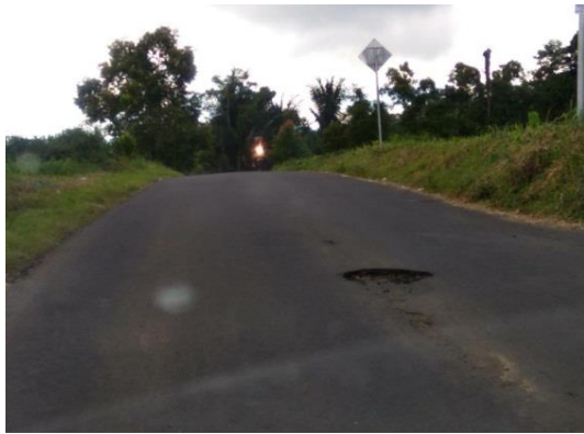
Gambar 9. Kondisi Jaringan Jalan Sumber : Penulis 2017
