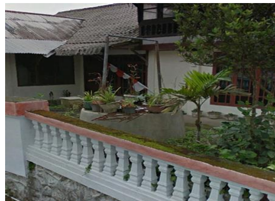
Gambar 13. Kondisi Jaringan Air Bersih Sumber : Penulis 2017
