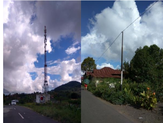
Gambar 12. Kondisi Jaringan Jalan Sumber : Penulis 2017
