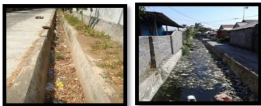
Gambar 7. Kondisi Eksisting Drainase
