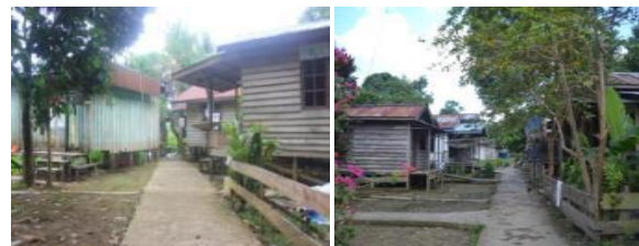
Gambar 2. Kondisi Jalan Bulu Perindu
