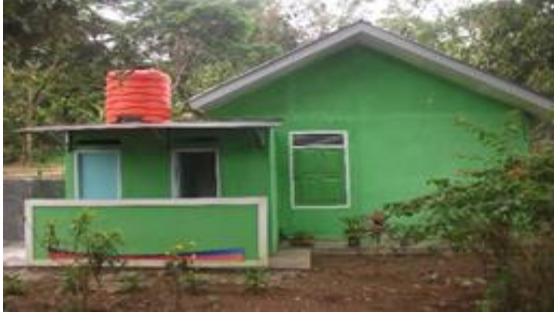
Gambar 3. Kondisi toilet umum di kawasan objek wisata.
