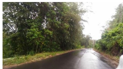
Gambar 0. 4 Kondisi Jalan ke Kota Manado Sumber: Dokumentasi dan Survey (Penulis, 2018)
