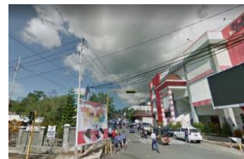
Gambar 3 Kondisi Koridor Jalan Ratahan-Amurang
