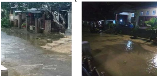
Gambar.4. Kondisi Eksisting dan Kondisi Ruas Tanpa Saluran
