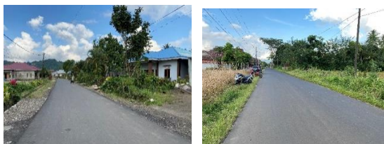
Gambar 6 Kondisi Jalan Penghubung
