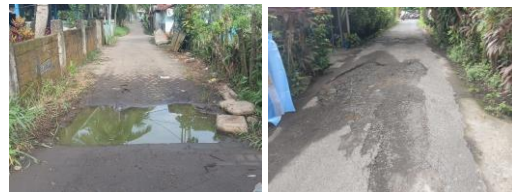
Dokumentasi Kondisi Jaringan Jalan
