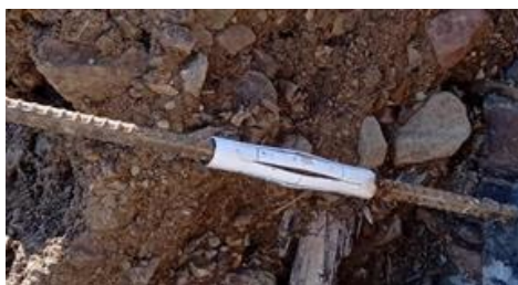
Gambar 6. Centralizer Yang Diletakkan Pada Nail Bar
