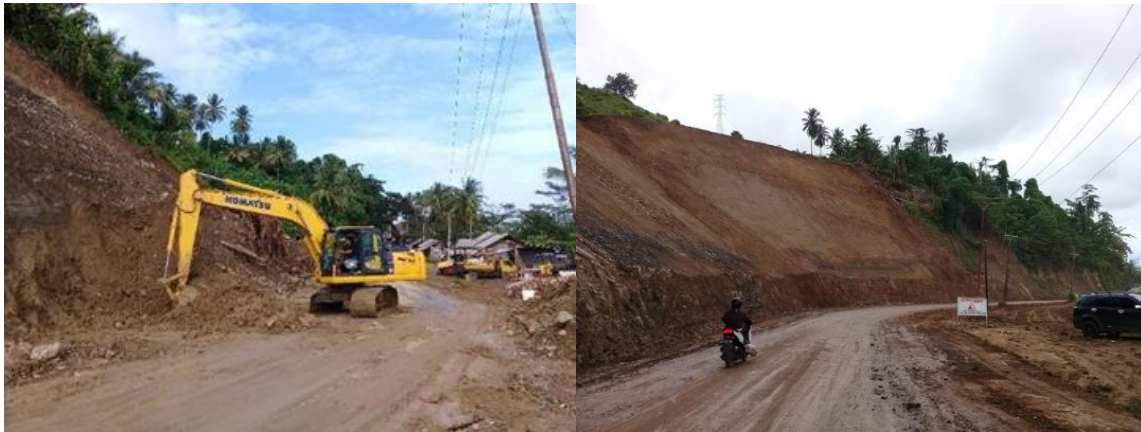
Gambar 2. Proses Merapihkan Lereng: Sebelum (kiri) dan Sesudah (kanan)
