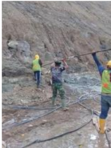
Gambar 5. Pemasangan Nail Bar Pada Lubang Bor
