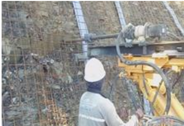
Gambar 3. Pengeboran Dengan Cara Kering Menggunakan Alat CRD (Bor Angin)
