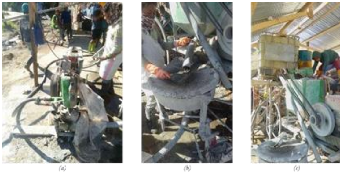
Gambar 7. a) Mesin Pompa, (b) Mesin Grouting Mixing, (c) Setelah Semua Bahan Grouting Dicampur Di Mesin Mixing Akan Disaring Kembali.
