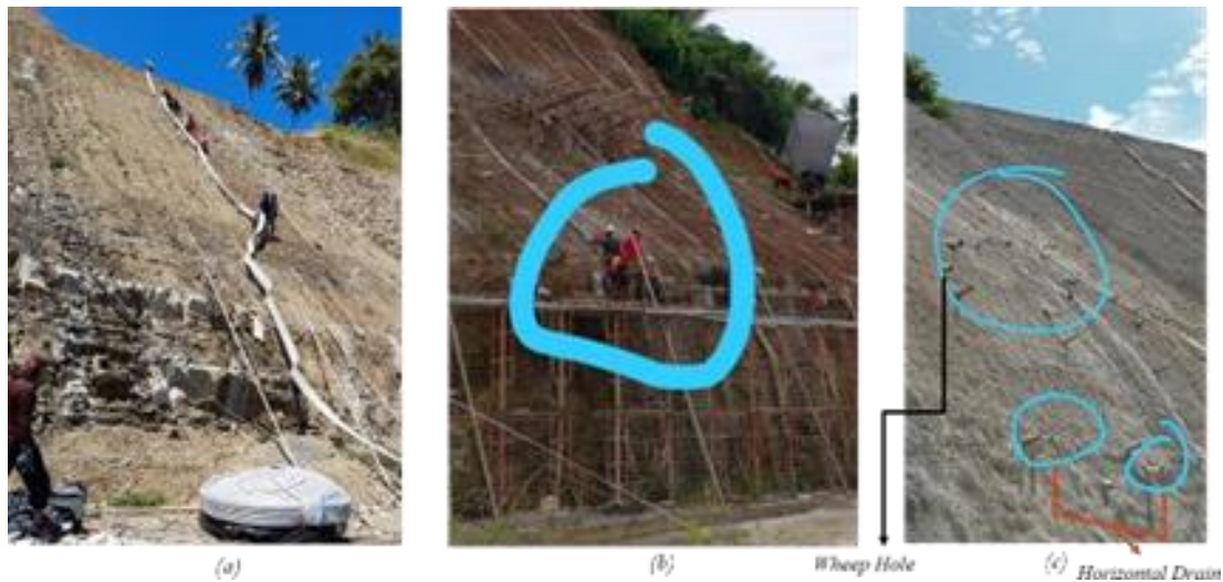
Gambar 9. (a) Pemasangan Geokomposite, (b) Pemasangan Horizontal Drain, (c) Horizontal Drain dan Weephole Setelah Pekerjaan Shootcrete
