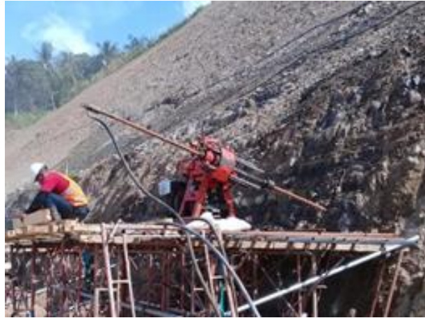
Gambar 4. Pengeboran Dengan Cara Basah Menggunakan Alat Rotary Hydraulic Drilling Machine (Bor Air)
