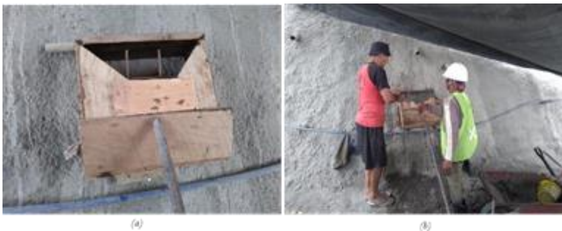
Gambar 14. (a) Pemasangan Bekisting Untuk Pelat Beton, (b)Pengecoran Pelat Beton.
