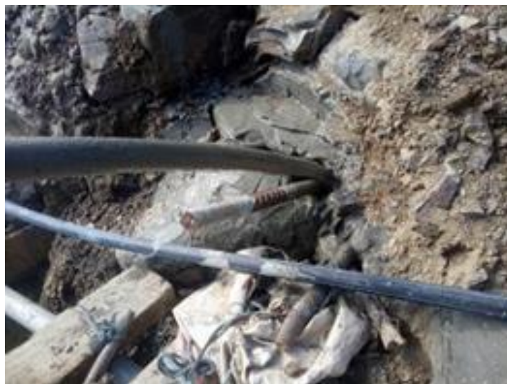
Gambar 8. Lubang Nailing Yang Sedang Di Grouting
