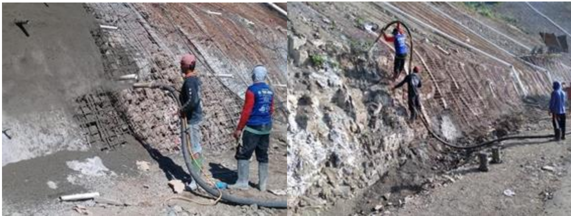
Gambar 12. Pekerjaan Shotcrete
