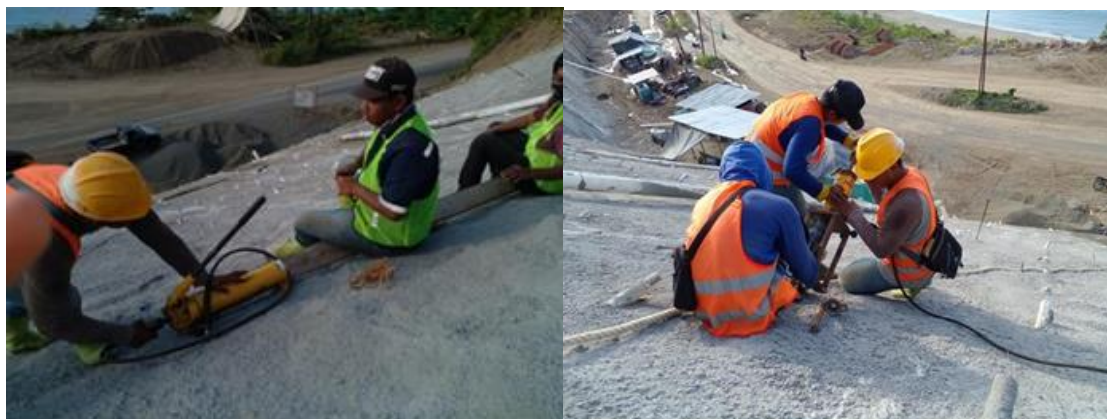
Gambar 13. Pekerjaan Pull-Out Test
