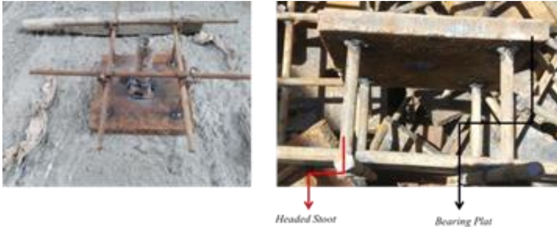
Gambar 13. Pemasangan Pelat Dan Baut Kunci
