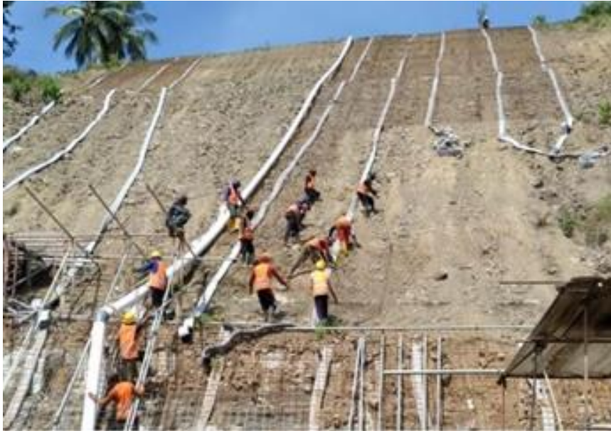
Gambar 10. Pemasangan Wire Mesh
