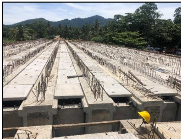
Gambar 2. Pemasangan Plat Deck
