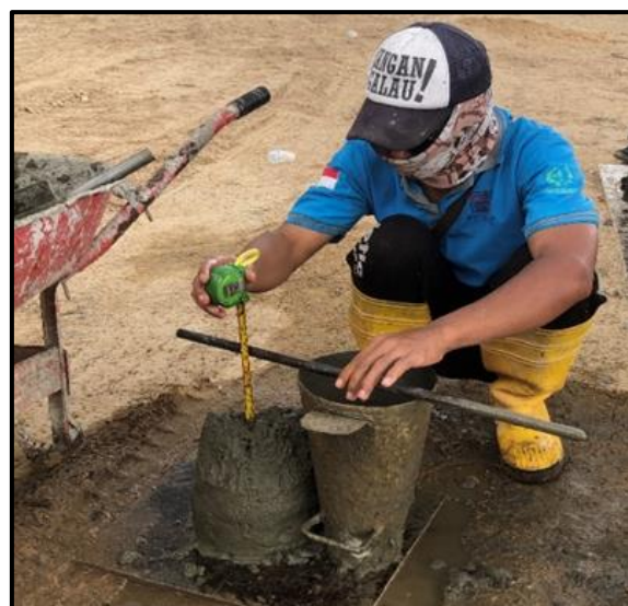
Gambar 13. Pengujian Slump Test
