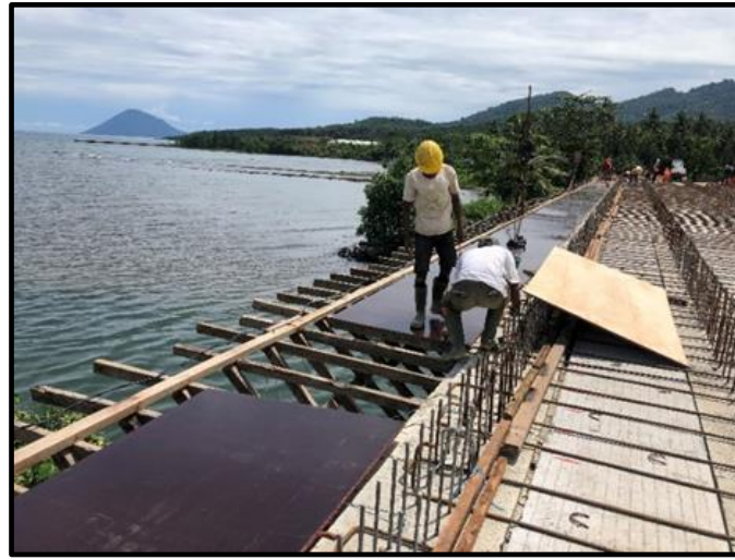
Gambar 4. Pemasangan Playwood (Bekisting Trotoar)
