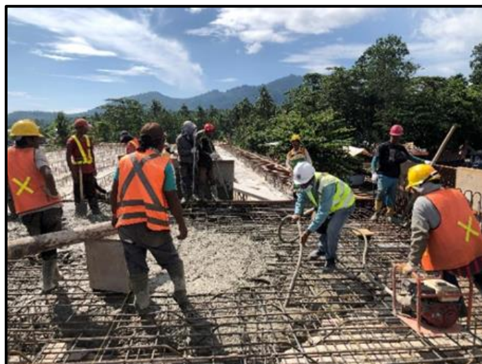
Gambar 19. Pemasangan Menggunakan Mesin Vibrator
