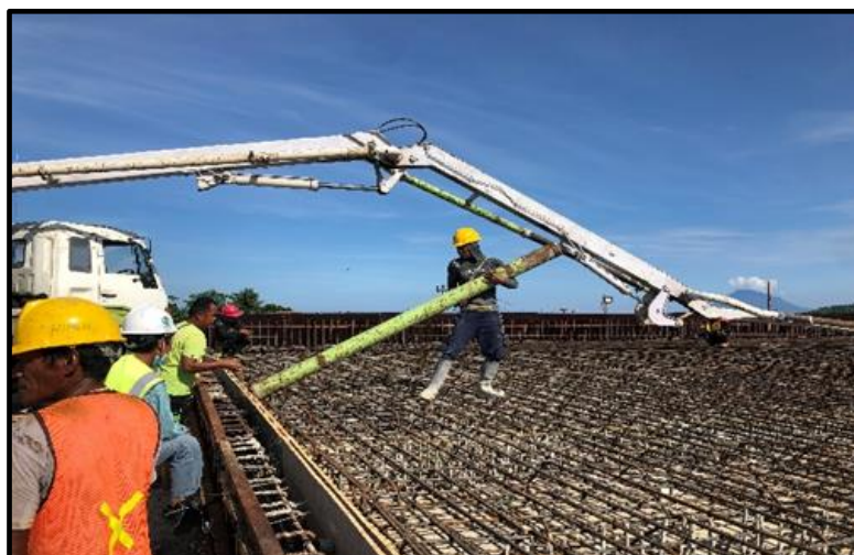
Gambar 16. Pipa Tremie ke Cetakan Beton
