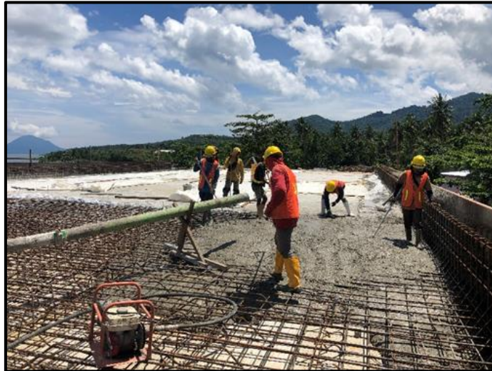
Gambar 17. Pengecoran Pada Sisi Plat Lantai
