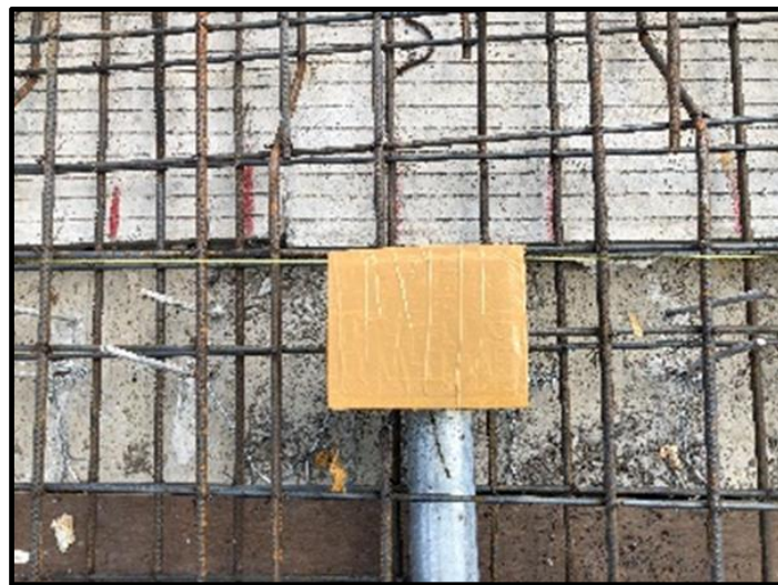
Gambar 8. Pemasangan Deck Drain
