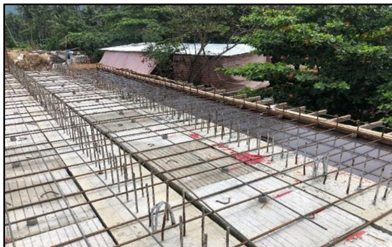
Gambar 6. Pemasangan Tulangan Utama dan Besi Pembagi
