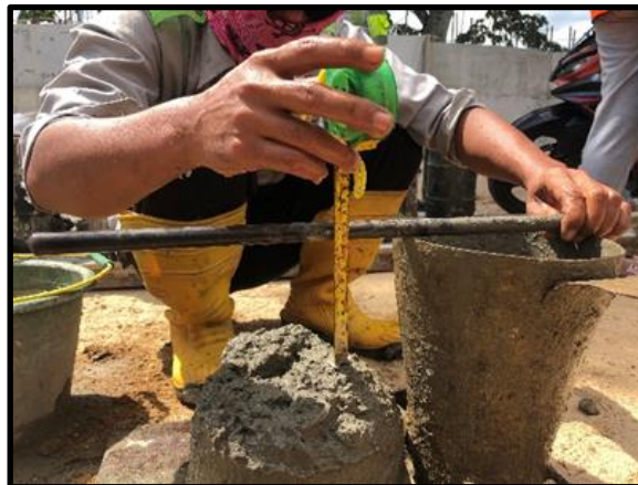
Gambar 15. Pengambilan Nilai Uji Slump
