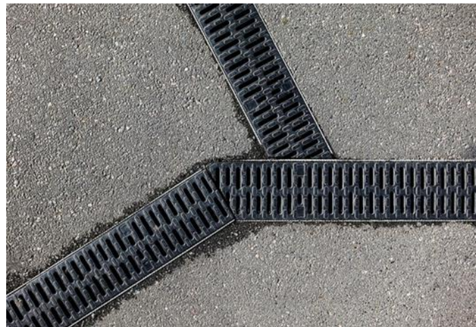
Gambar 3. Grill pada Pertemuan Ruas Jalan (sumber: internet)
