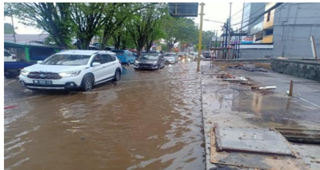
Gambar 1. Kondisi Ruas Jalan Bethesda (Manado) yang tergenang
