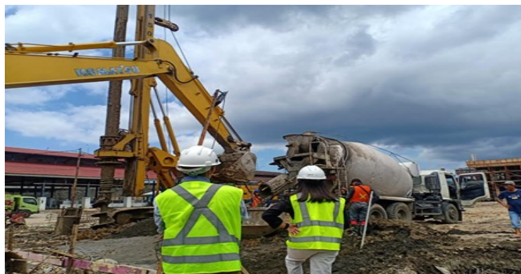
Gambar 9. Proses Pengecoran
