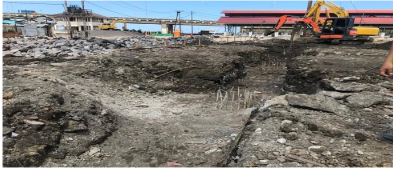
Gambar 6. Pembuatan Drainase dan Kolam Air
