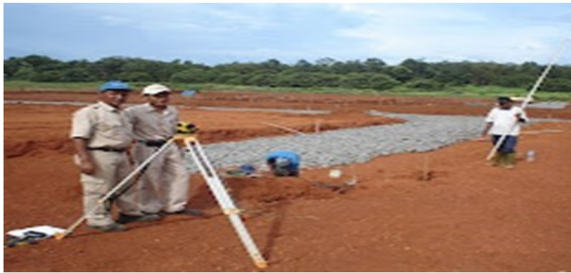
Gambar 4. Penentuan Titik Pondasi
