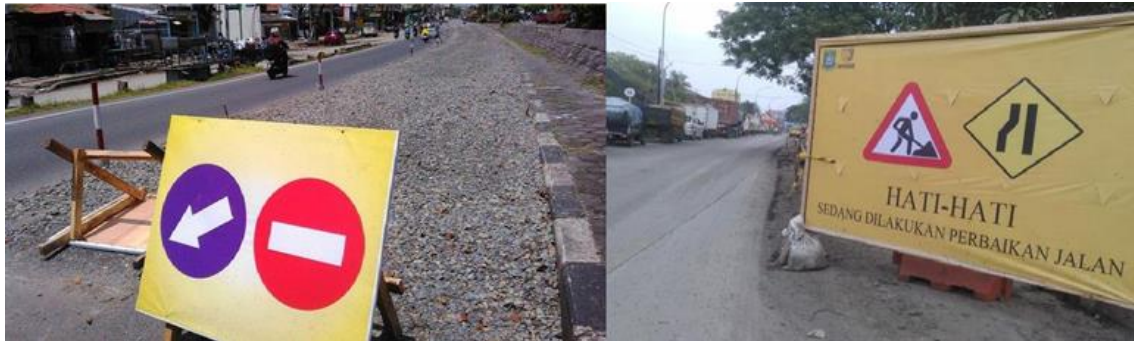
Gambar 3. Pengaturan Rambu Lalu Lintas di Lokasi Proyek
