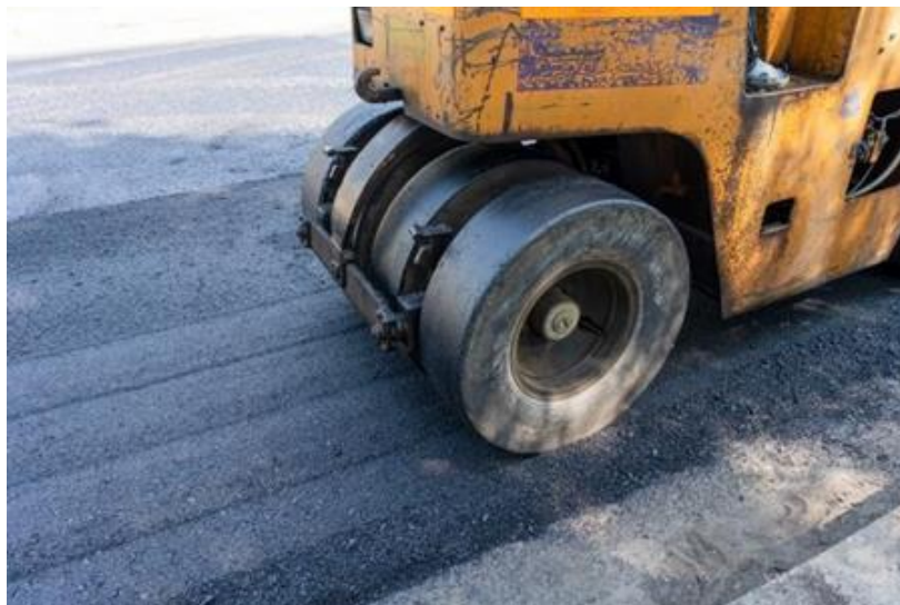
Gambar 7. Pemdatan Kedua menggunakan Tire Roller
