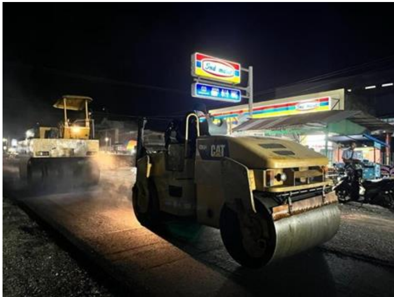
Gambar 6. Pemdatan Pertama menggunakan Tandem Roller
