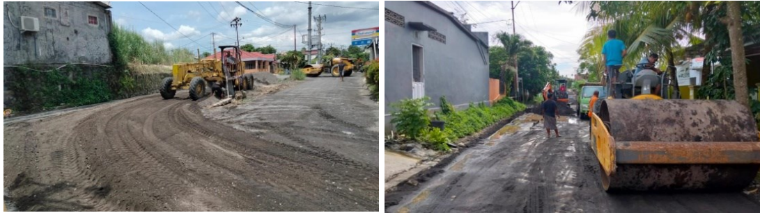
Gambar 7. Penyiapan Badan Jalan Dengan Proses Pemasatan
