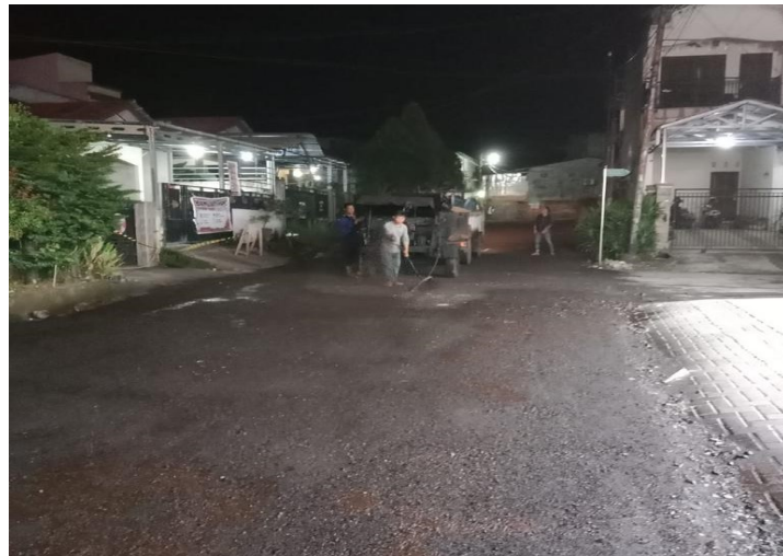
Gambar 9. Penyemprotan Lapis Resap Pengikat
