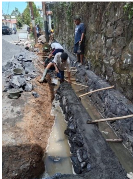
Gambar 5. Pembuatan Saluran Air
