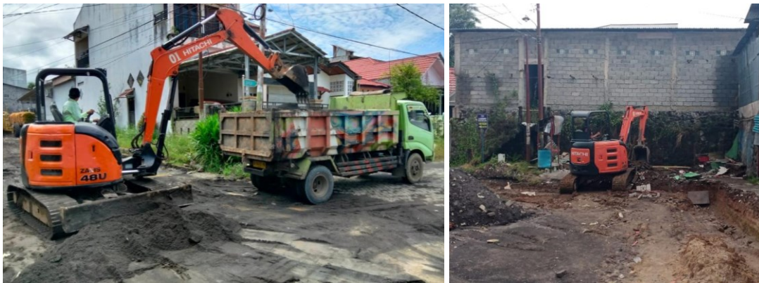
Gambar 3. Pembongkaran Jalan Paving Block dan Bangunan Pangkalan Ojek
