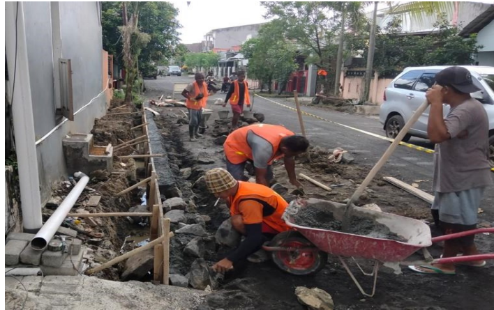
Gambar 11. Pekerjaan Pasangan Batu
