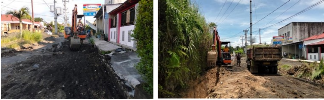
Gambar 6. Galian Biasa Untuk Persiapan Badan Jalan dan Pekerjaan Drainase
