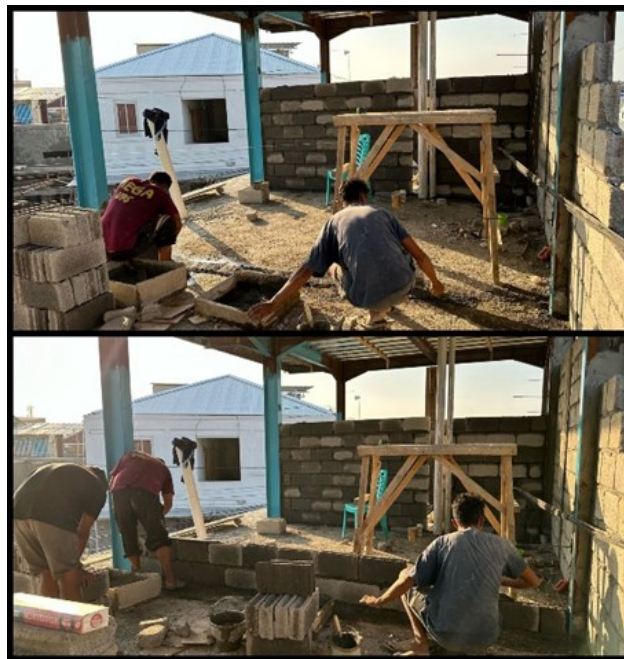
Gambar 5. Pemasangan Batako (Dokumentasi, 2023)
