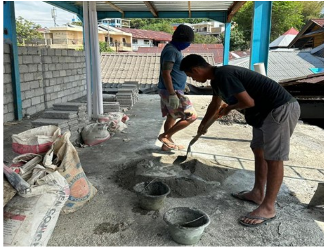
Gambar 4. Pengadukan Semen dan Pasir (Dokumentasi, 2023)
