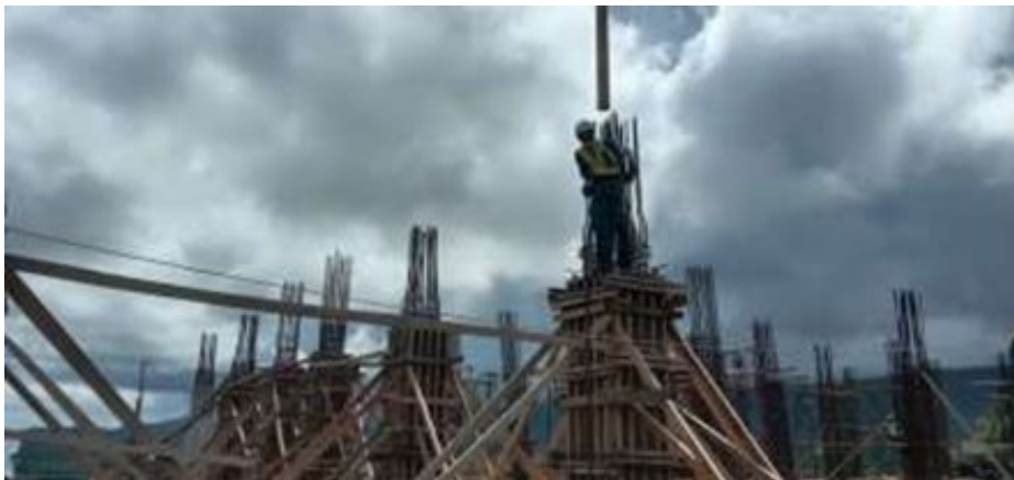
Gambar 12. Pengecoran Kolom
