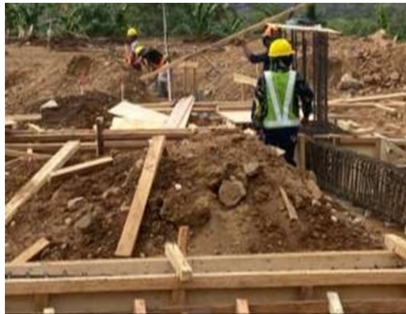
Gambar 8. Perangkaian Pembesian Sloof
