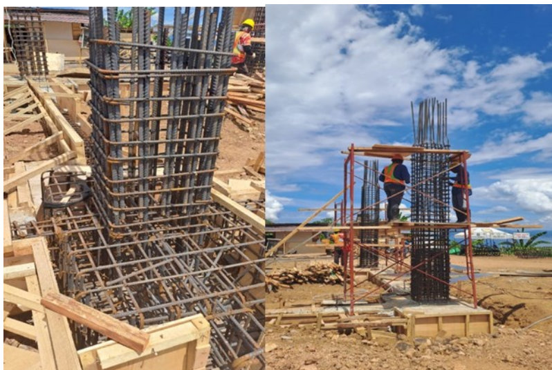
Gambar 11. Pembesian Kolom
