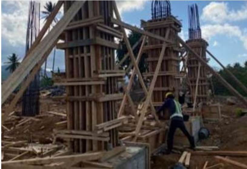
Gambar 13. Pembongkaran Bekisting
