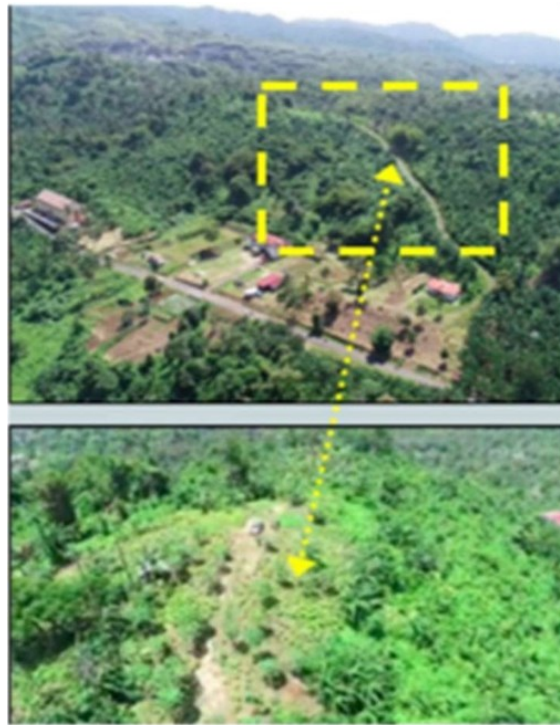
Gambar 1. Lokasi Proyek Pembangunan Mako Brimob
