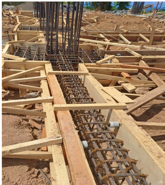
Gambar 10. Pemasangan Bekisting Sloof
