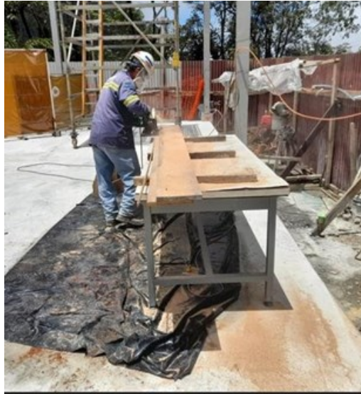
Gambar 9. Pabrikasi Bekisting Sloof
