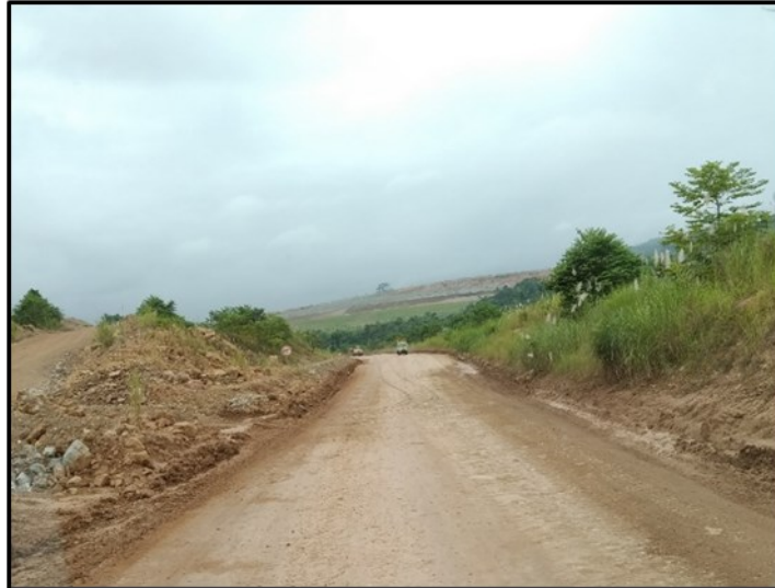
Gambar 2. Kondisi Jalan Angkut
