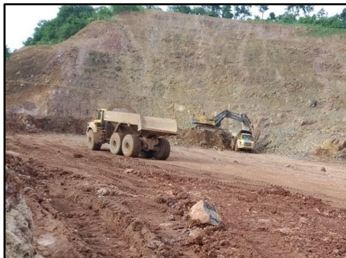
Gambar 1. Kondisi Front Penambangan Saat Kegiatan Loading Material
