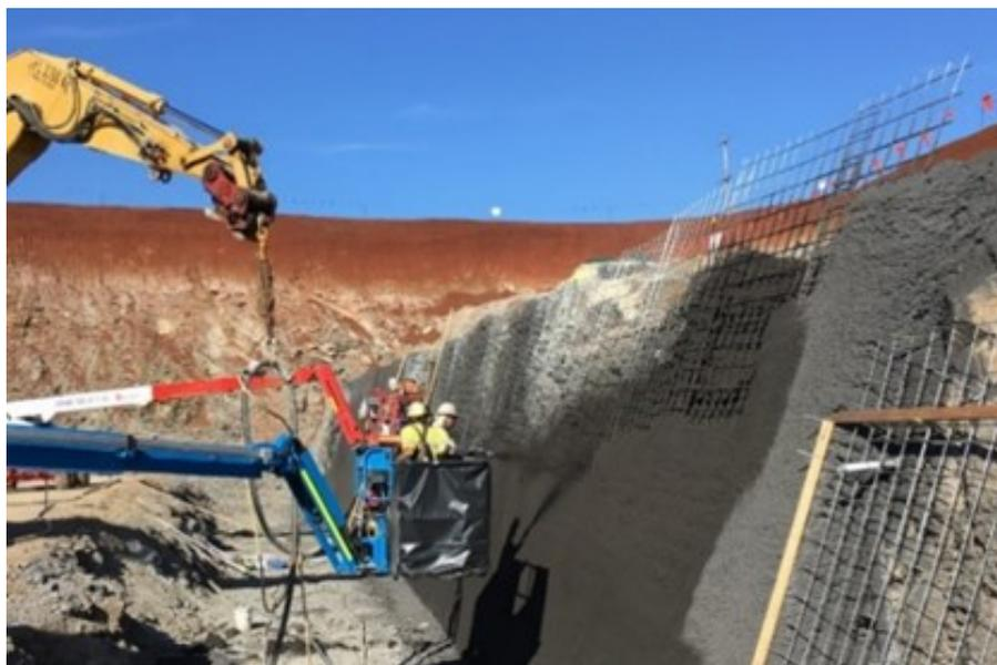
Gambar 3. Pengaplikasian Shotcrete pada Lereng (Sumber: qpsengineering)
