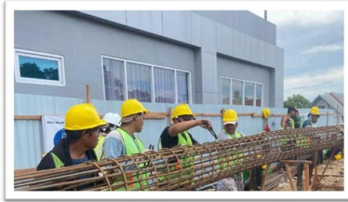
**Gambar 11.** Perakitan dan Penyambungan Besi Penulangan
