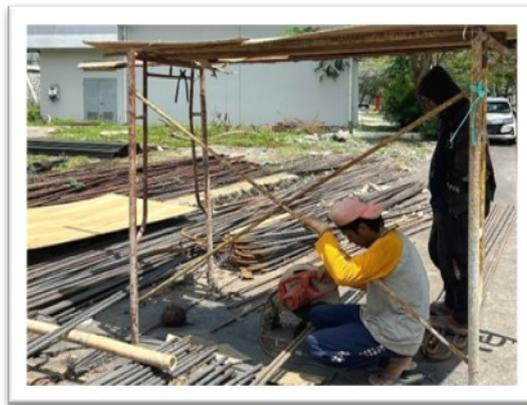
Gambar 9. Pabrikasi Pemotongan besi
