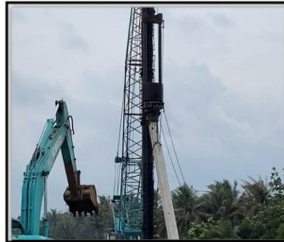
Gambar 18. Diesel hammer dan Tiang Pancang Diangkat
