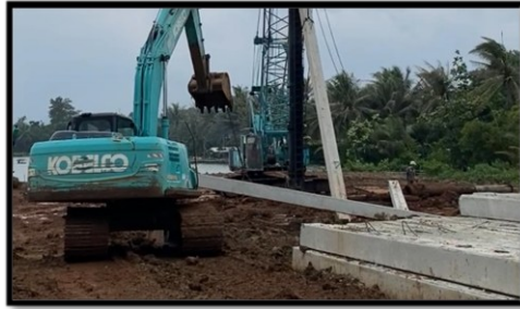
Gambar 16. Excavator Mendekatkan Tiang Pancang Ke Crane Pancang
