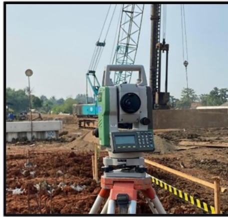
Gambar 14. Penentuan Titik-Titik Pemancangan
