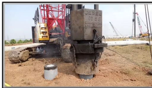
Gambar 23. Topi Diesel Hammer Hampir Menyentuh Tanah
