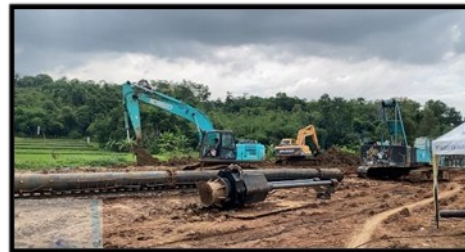
Gambar 12. Mobilisasi dan Penurunan Tiang Pancang
