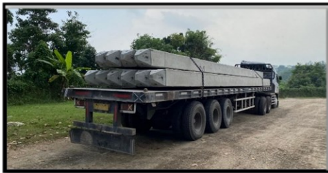
Gambar 11. Mobilisasi dan Penurunan Tiang Pancang
