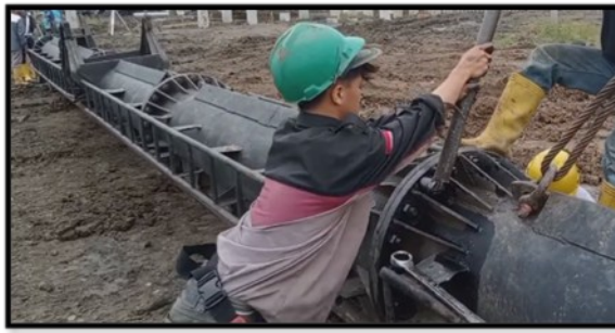
Gambar 13. Persettingan Alat Pancang
