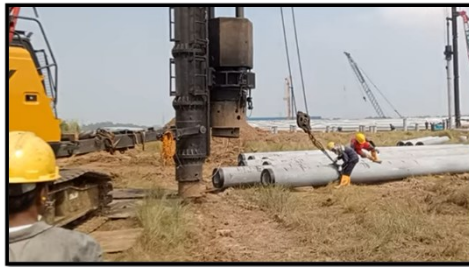
Gambar 17. Tiang Pancang Diikat Dengan Kawat Crane
