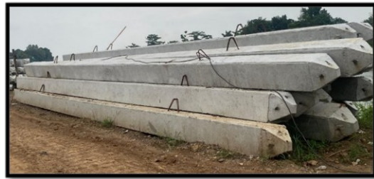
Gambar 11. Mobilisasi dan Penurunan Tiang Pancang
