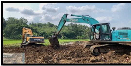
Gambar 10. Penggantian Tanah Permukaan Lahan Pemancangan
