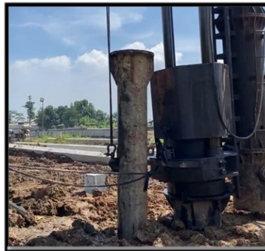
Gambar 26. Menarik dolly pancang Keluar dari Dalam Tanah
