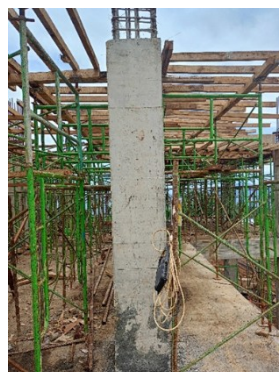
Gambar 12. Pembongkaran Bekisting Kolom
