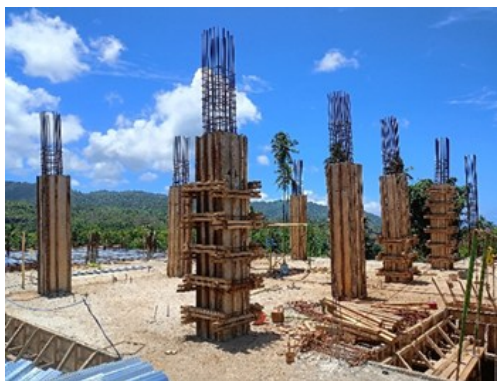
Gambar 10. Pemasangan Bekisting
