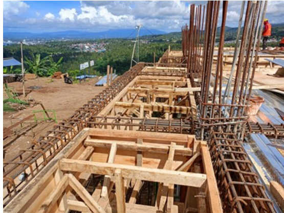
Gambar 5. Penulangan pada Balok
