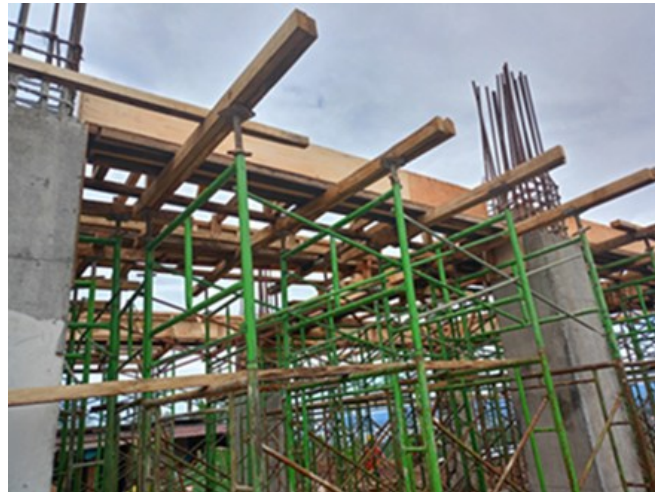
Gambar 3. Pemasangan Perancah
