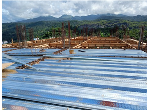
Gambar 8. Pemasangan Floordeck /Bondek
