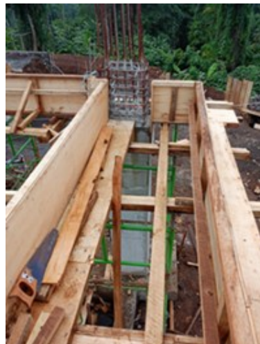
Gambar 4. Pemasangan Bekisting Balok
