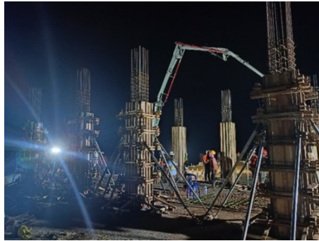
Gambar 11. Pengecoran Kolom Lantai Dua
