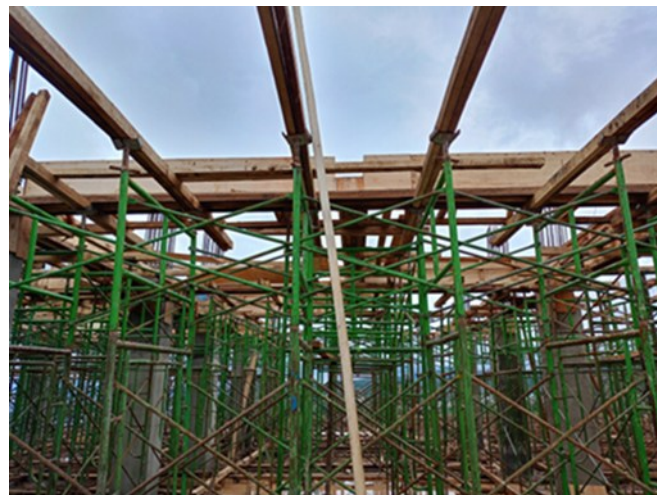
Gambar 7. Pemasangan Perancah Plat lantai
