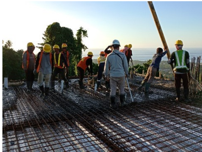
Gambar 6. Pengecoran Balok dan Plat Lantai
