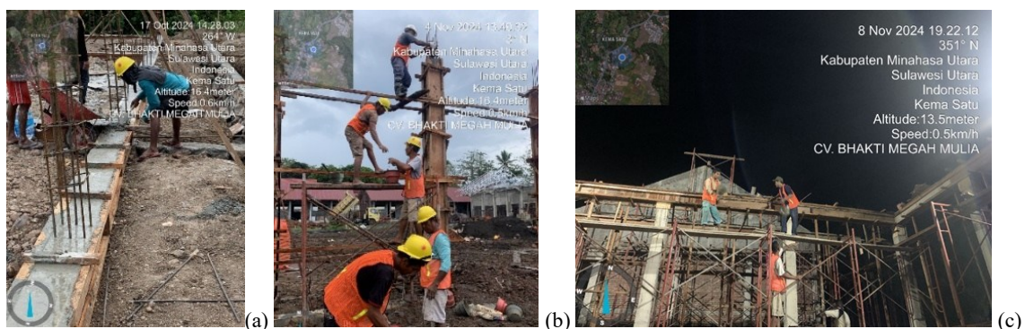
Gambar 5. (a) Pengecoran Sloof; (b) Pengecoran Kolom; (c) Pengecoran Ring Balok.
