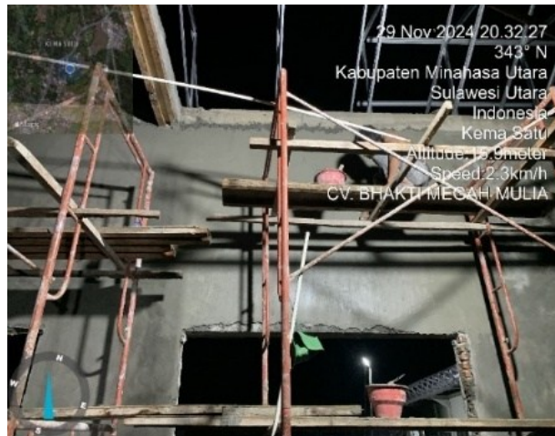
Gambar 6. Pekerjaan Acian Dinding
