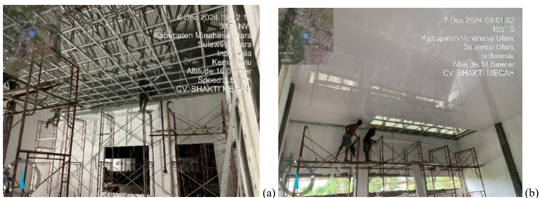
Gambar 9. (a) Pekerjaan Pemasangan Rangka Hollow; (b) Pekerjaan Pemasangan Plafon PVC.
