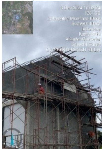
Gambar 7. Pekerjaan Acian Sopi – sopi
