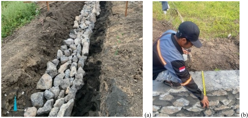
Gambar 4. (a) Pasangan Batu Kosong; (b) Pengukuran Kepala Pondasi.
