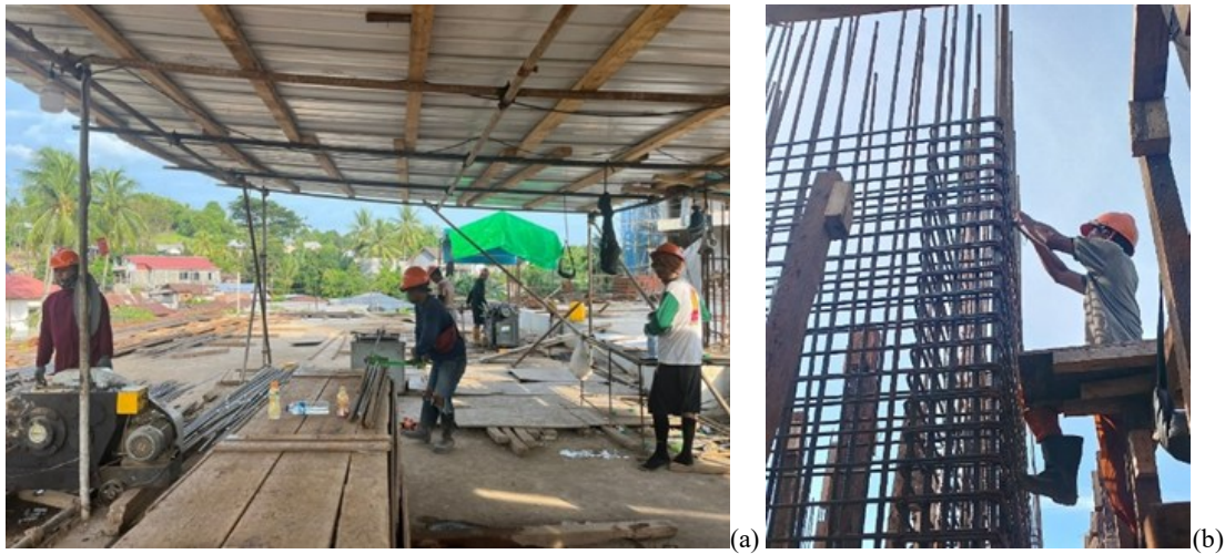
Gambar 3. (a) Pabrikasi Besi; (b) Pemasangan Tulangan
