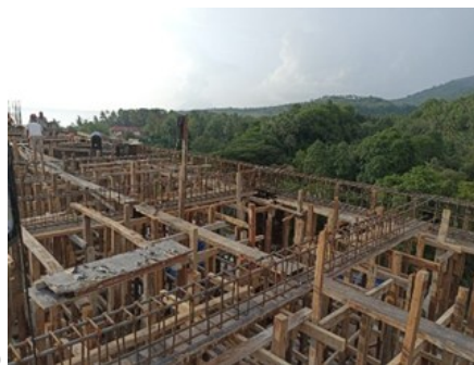
Gambar 5. (a) Bekisting Balok; (b) Pembesian Balok
