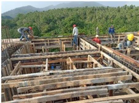
Gambar 5. (a) Bekisting Balok; (b) Pembesian Balok
