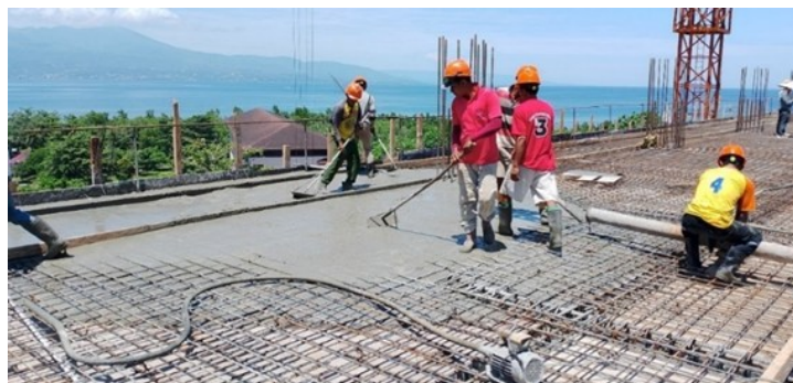
Gambar 6. Pengecoran Plat Lantai
