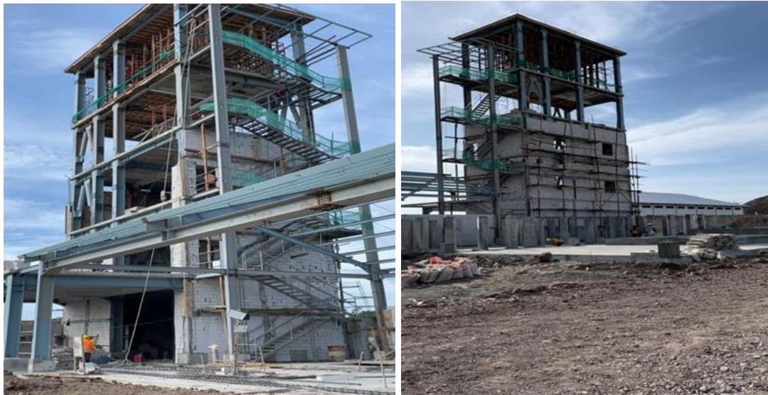
Gambar 1. Tampak Proyek Bangunan Factory: Depan (kiri) dan Belakang (kanan)
