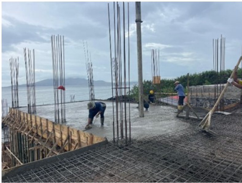
Gambar 14. Pengecoran Plat Lantai
