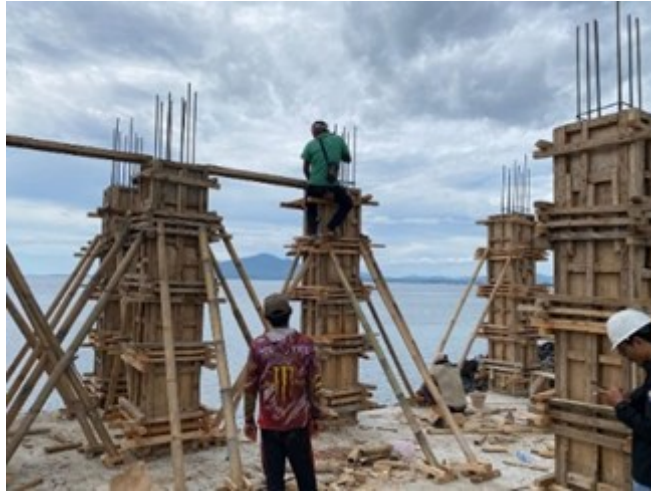
Gambar 10. Bekisting Kolom
