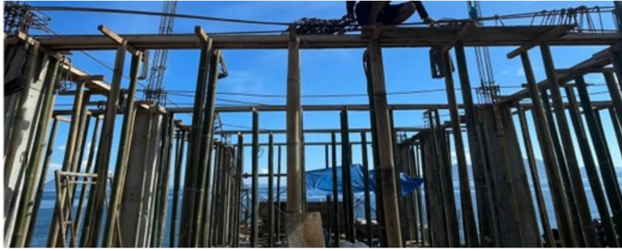
Gambar 5. Pemasangan Perancah Balok
