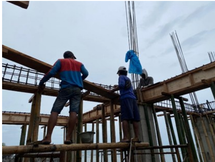
Gambar 7. Pemasangan Bekisting Balok
