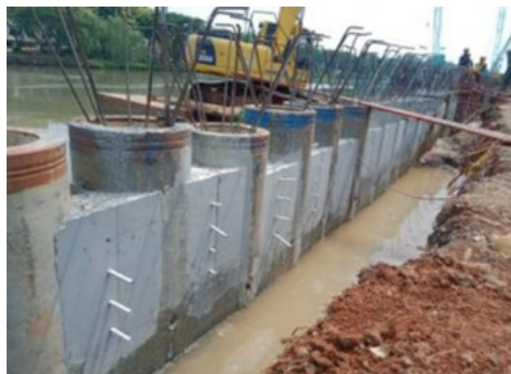
Gambar 13. Pekerjaan Pengecoran Beton Pengaman CT Joint
