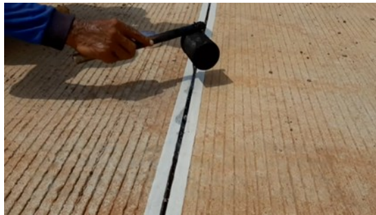
Gambar 15. Pekerjaan Dilatasi Aspal Filter
