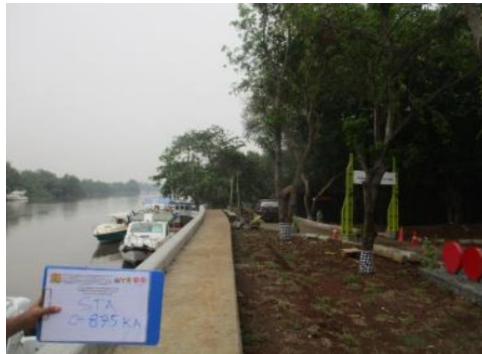
Gambar 16. Pekerjaan Timbunan Tanah Merah
