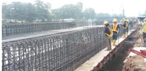
Gambar 12. Pekerjaan Penulangan Ulir
