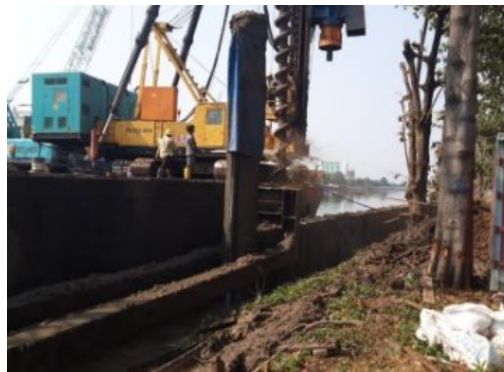
Gambar 7. Pekerjaan Pemasangan Tiang Pipa Beton
