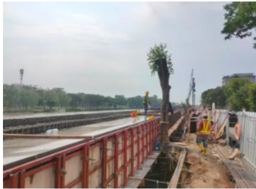
Gambar 14. Pekerjaan Pengecoran Capping Beam
