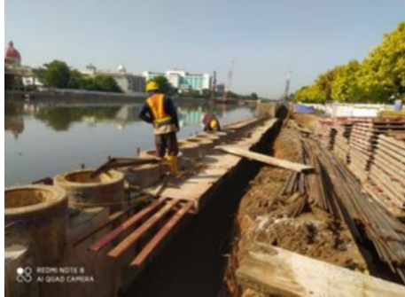
Gambar 11. Pekerjaan Bekisting Pengisi Spun Pile
