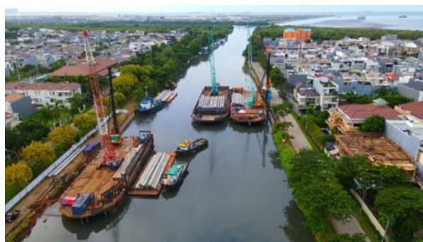
Gambar 6. Pekerjaan Pengadaan Tiang Pipa Beton
