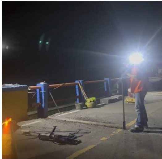
Gambar 6. Pemotongan dan Pembongkaran Sambungan
