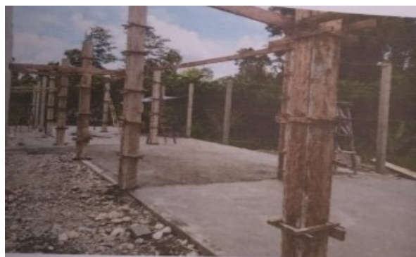
Gambar 5. Bekisting Kolom yang Telah Terpasang
