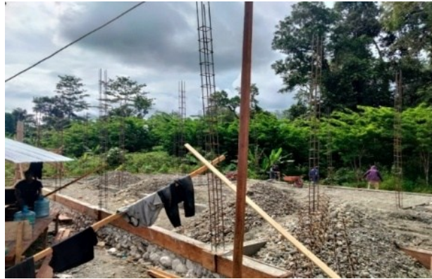
Gambar 4. Tulangan Kolom yang Telah Terpasang
