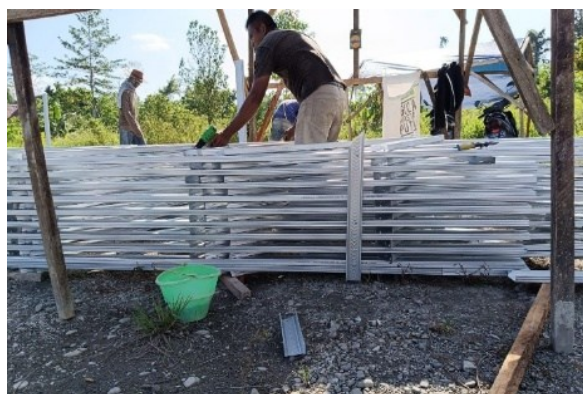
Gambar 8. Persiapan Rangka Baja Ringan
