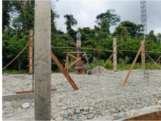
Gambar 6. Penuangan Adukan ke dalam Bekisting
