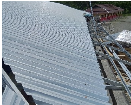
Gambar 10. Pemasangan Atap Spandek 0.3 mm
