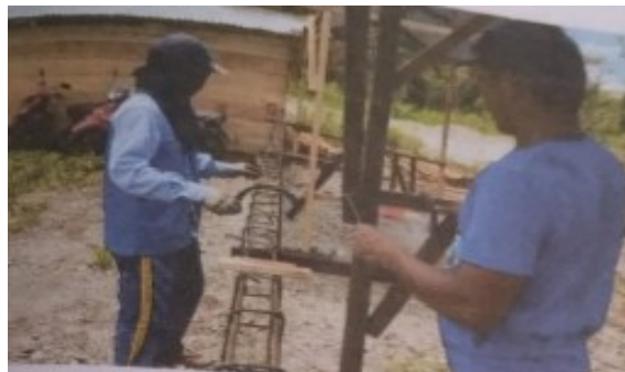
Gambar 3. Pekerjaan Pembesian Tulangan Kolom
